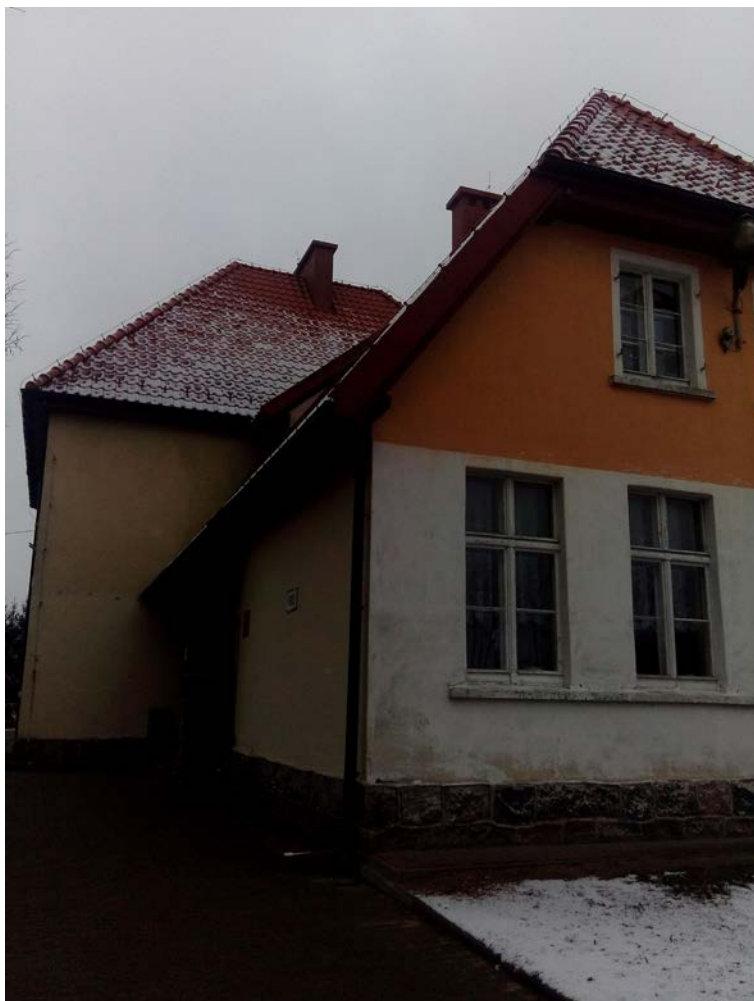
Fot. 2. Nowe pokrycie dachowe oraz opierzenie są w b. dobrym stanie.
