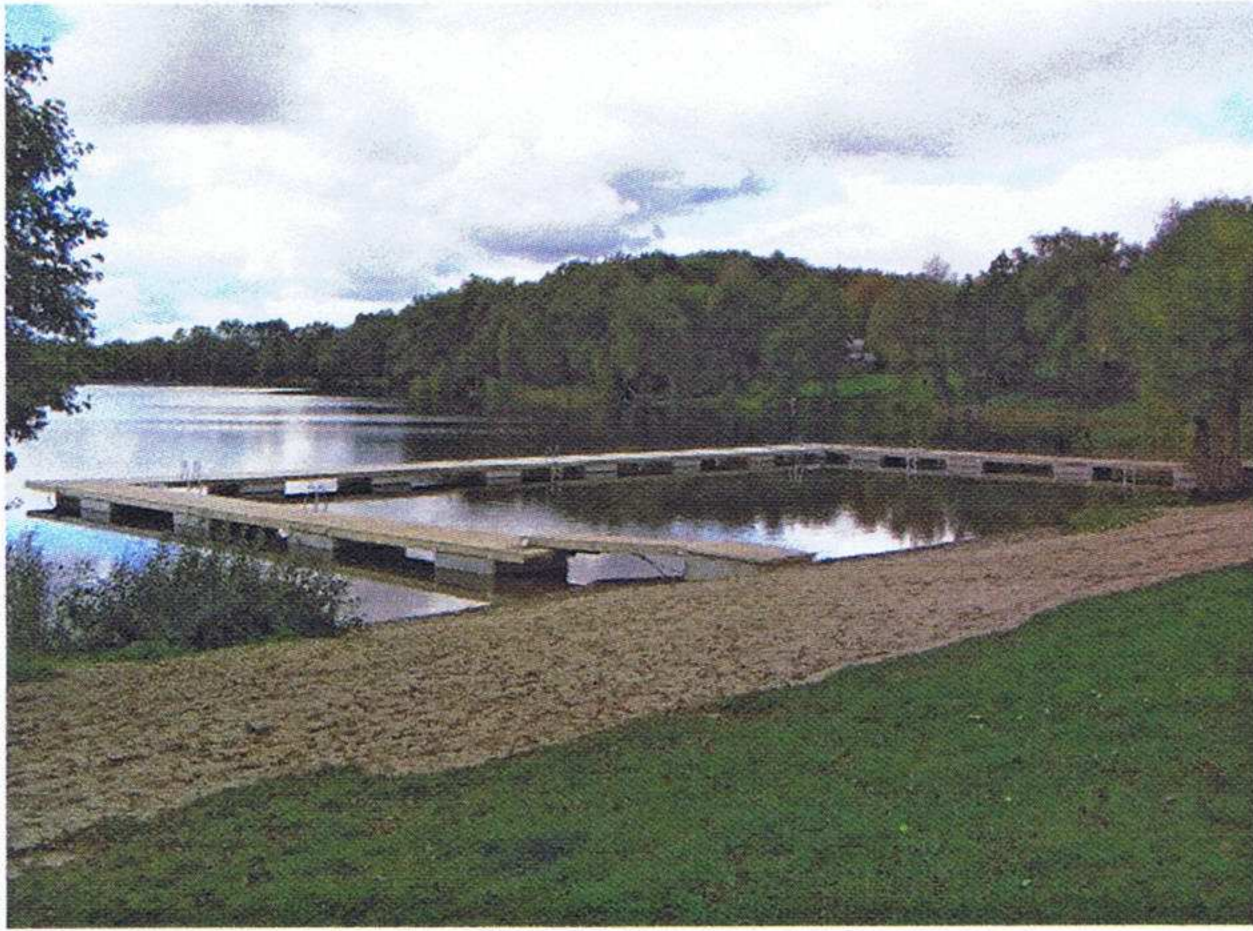
Rys.3. Fotografia zrealizowanego pomostu z elementów prefabrykowanych.
