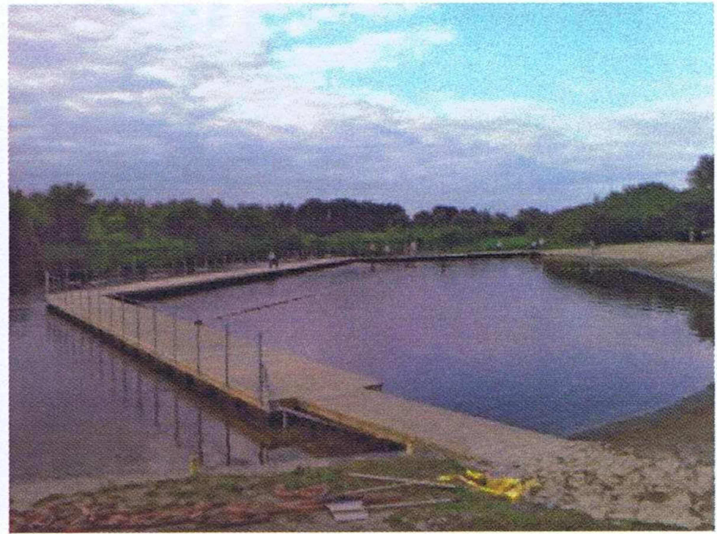
Rys.3. Fotografia zrealizowanego pomostu z elementów prefabrykowanych.
