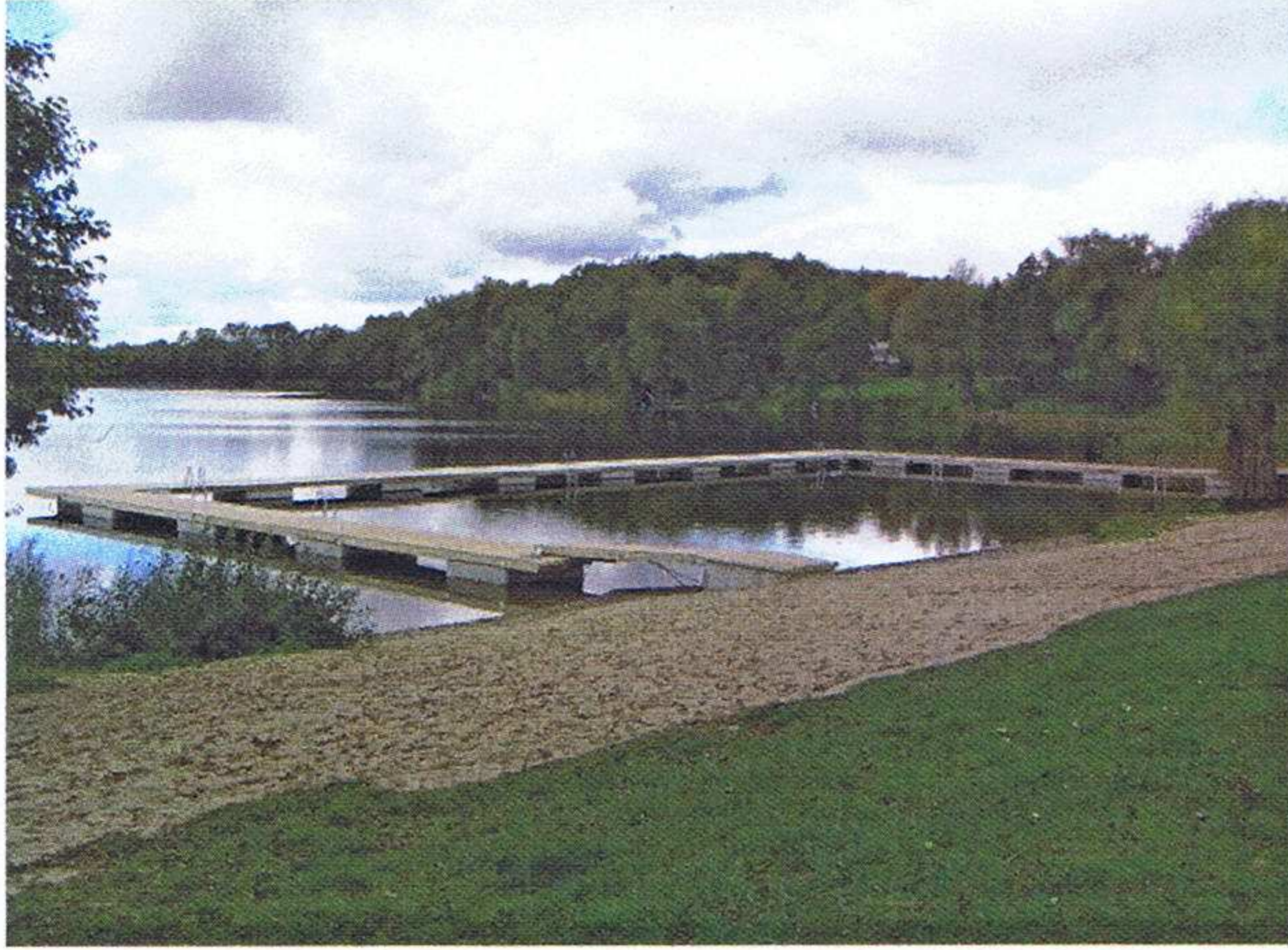
Rys.3. Fotografia zrealizowanego pomostu z elementów prefabrykowanych.
