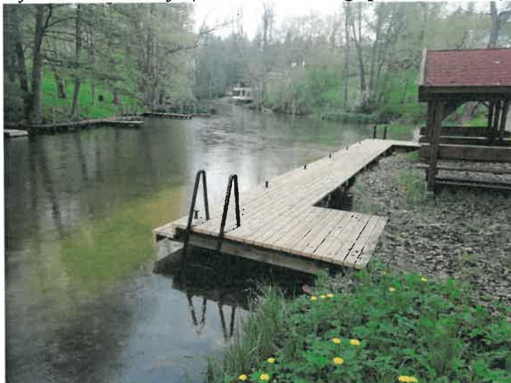
Przykładowa realizacja (remont drewnianego pomostu w Krutyńi
