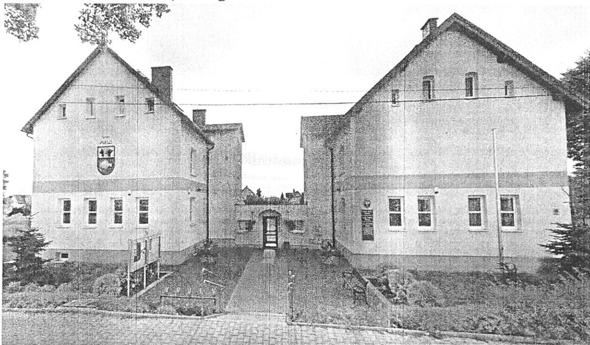
Fot 1. Budynek Widok ogólny.
